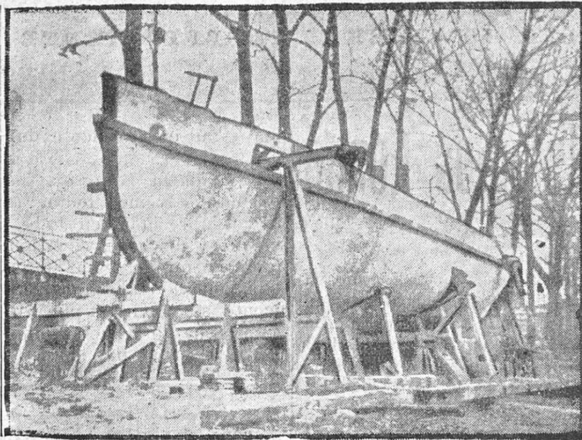
Construcción de un barco de cemento armado
