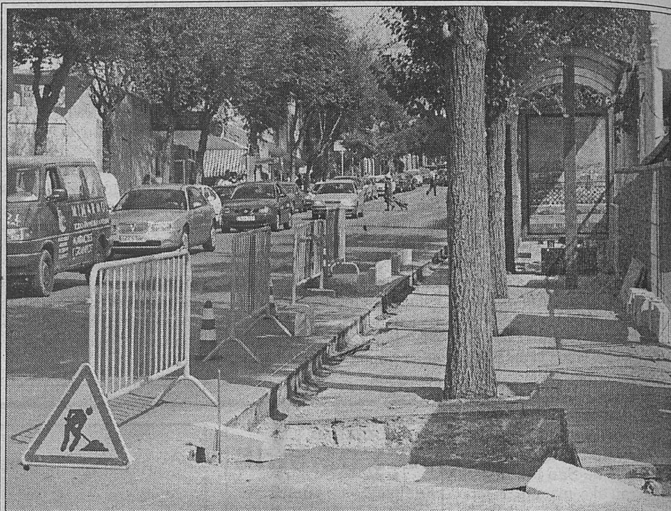
Además de las losetas antideslizantes, los trabajos incluyen la instalación de unos nuevos bordillos. MANU CANTERO
