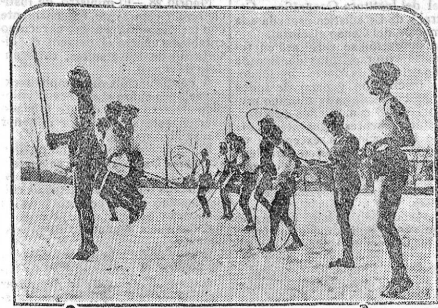
Una fotografía del tiempo nuevo. Cultura física de altura... y de nieve. No se puede pedir más modernismo...
