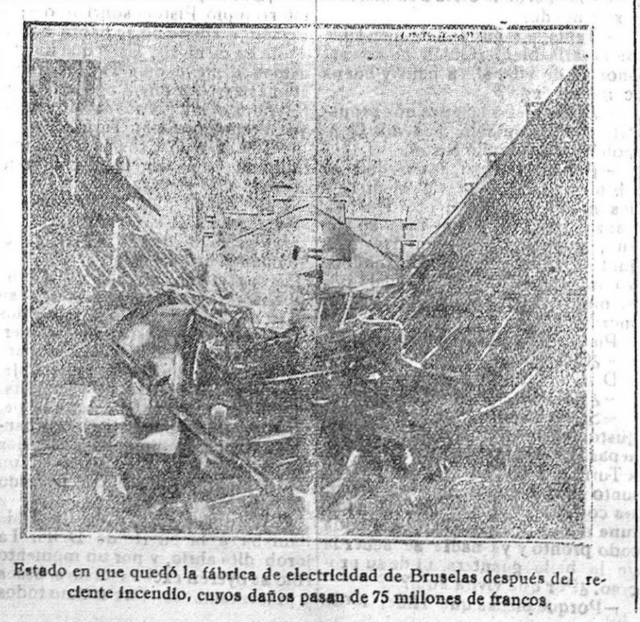
Estado en que quedó la fábrica de electricidad de Bruselas después del reciente incendio, cuyos daños pasan de 75 millones de francos.
