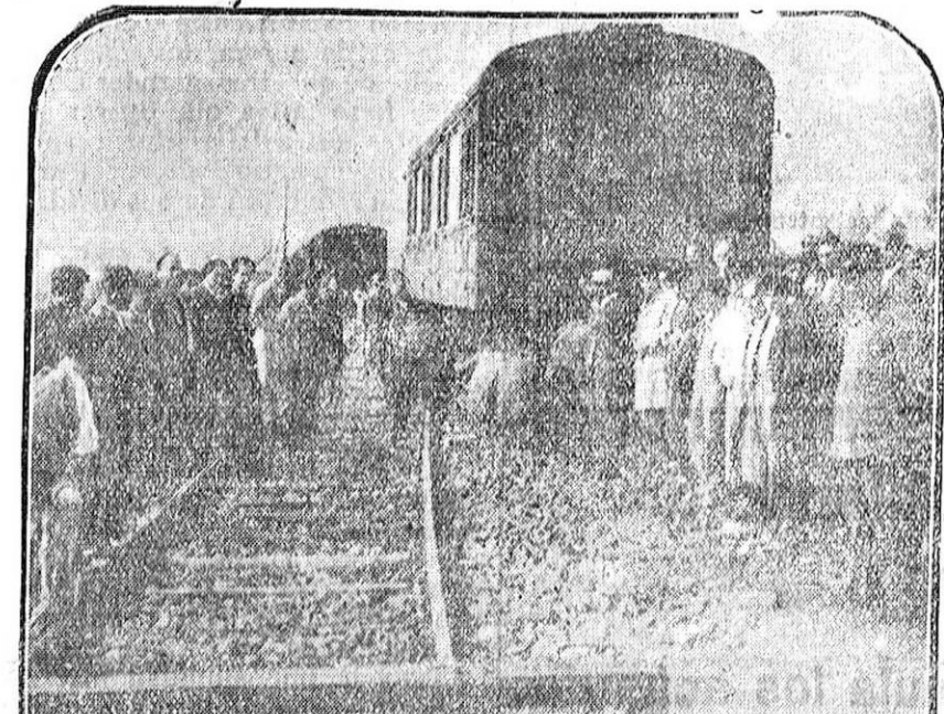
Los obreros de ferrocarriles reparando la avería ocasionada con motivo del descarrilamiento del mixto de Galicia.
