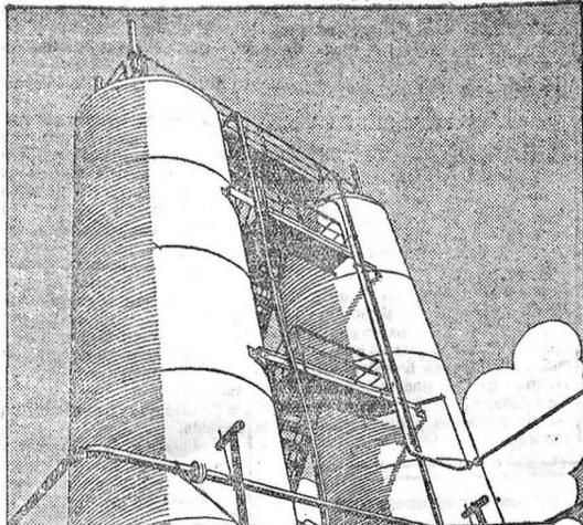
(arriba) Los nuevos imponentes tanques depósitos - altos como una casa de cuatro pisos - al interior de los cuales se efectúa la eliminación de las impurezas del aceite
