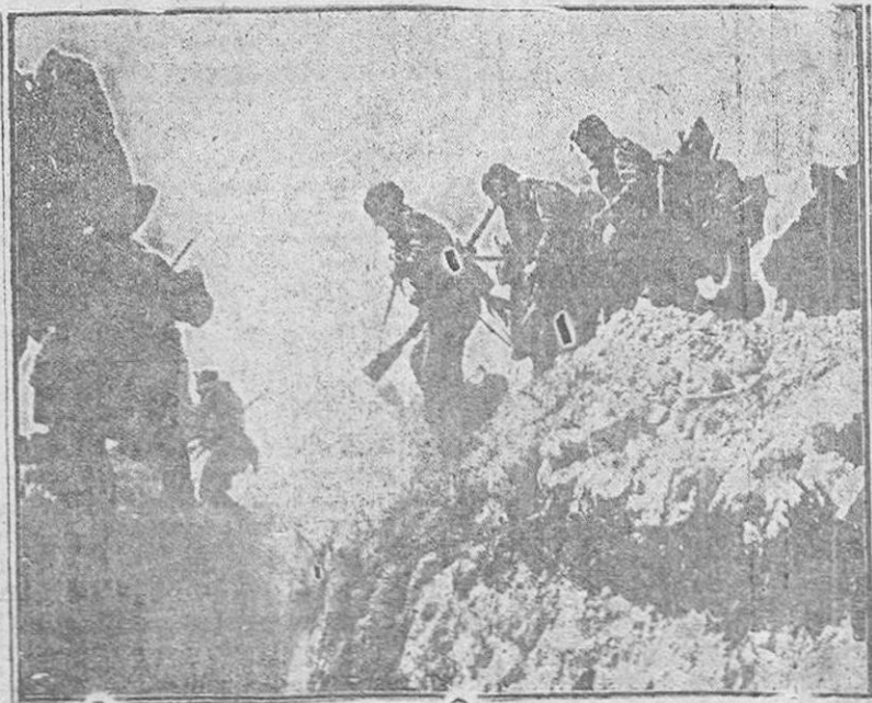
Hacia Castellón.—Atravesando una trinchera, de la que acaban de huir los rojos.
