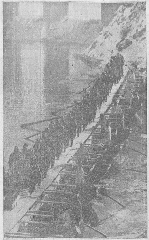
Bajo el rigor del invierno, los pontoneros alemanes improvisan un puente de barcas sobre un afluente del Rin para dar paso a una columna
