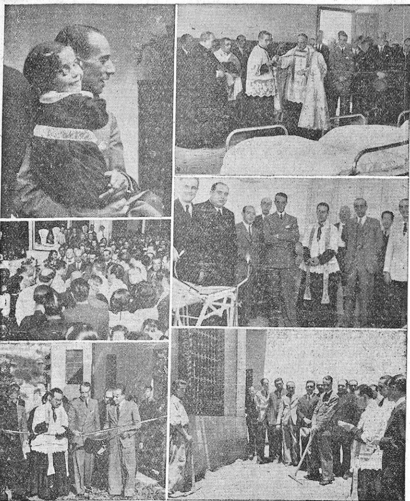
EN EL SEGUNDO ANIVERSARIO DE POSESIONARSE LA GESTORA MUNICIPAL, EL CAMARADA GALLEGO Y BURÍN INAUGURÓ IMPORTANTES SERVICIOS MUNICIPALES: LAS FOTOS RECOGEN LA BENDICIÓN E INAUGURACIÓN DE UN ORFELINATO, UN DISPENSARIO, LA PESCADERÍA REFORMADA, LA PRIMERA DEMOLICIÓN EN LA MANIGUA Y LA APERTURA DE LA CALLE DE PAGES. ESTOS NO SON MÁS QUE ALGUNOS TESTIMONIOS DE SU AMPLIO PLAN DE URBANIZACIÓN
