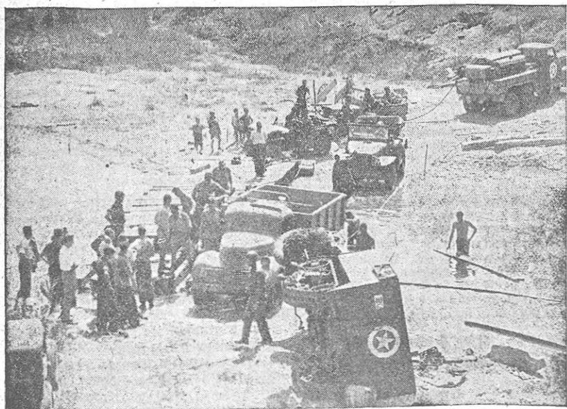
Un destacamento de ingenieros del Ejército americano construye apresuradamente un puente de pontones sobre un río.—(Foto WHITE).
