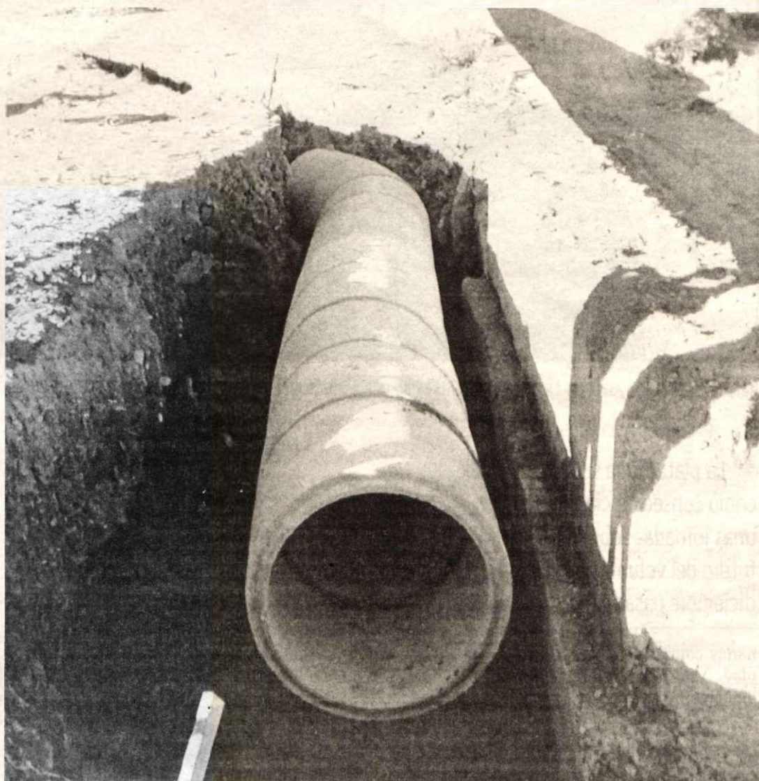
Obras de mejora.
