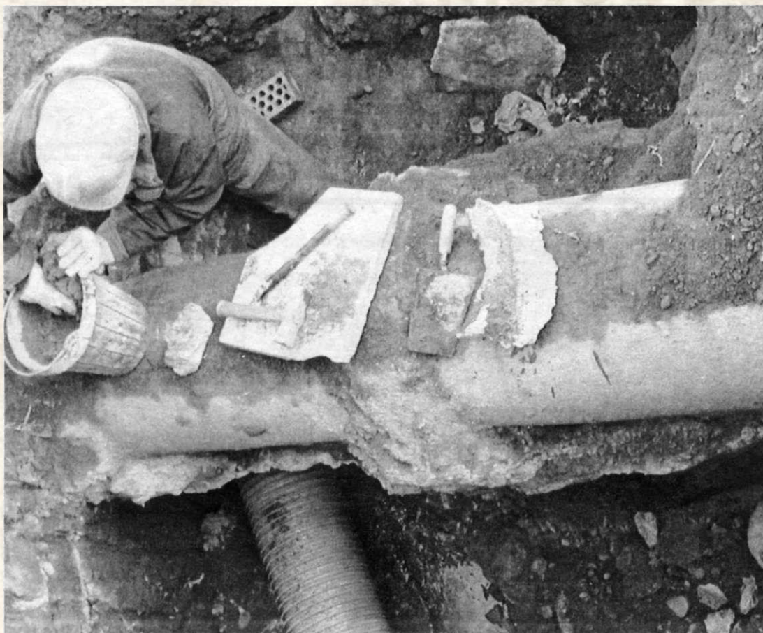
Reparación de unas conducciones.
