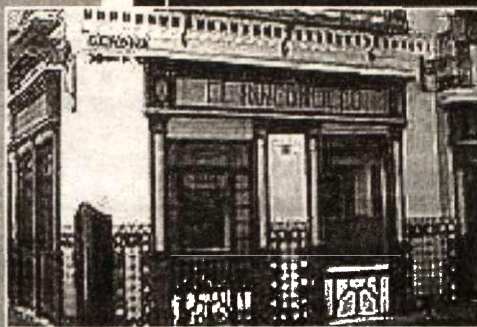
Fachada del bar en la calle Gerona
