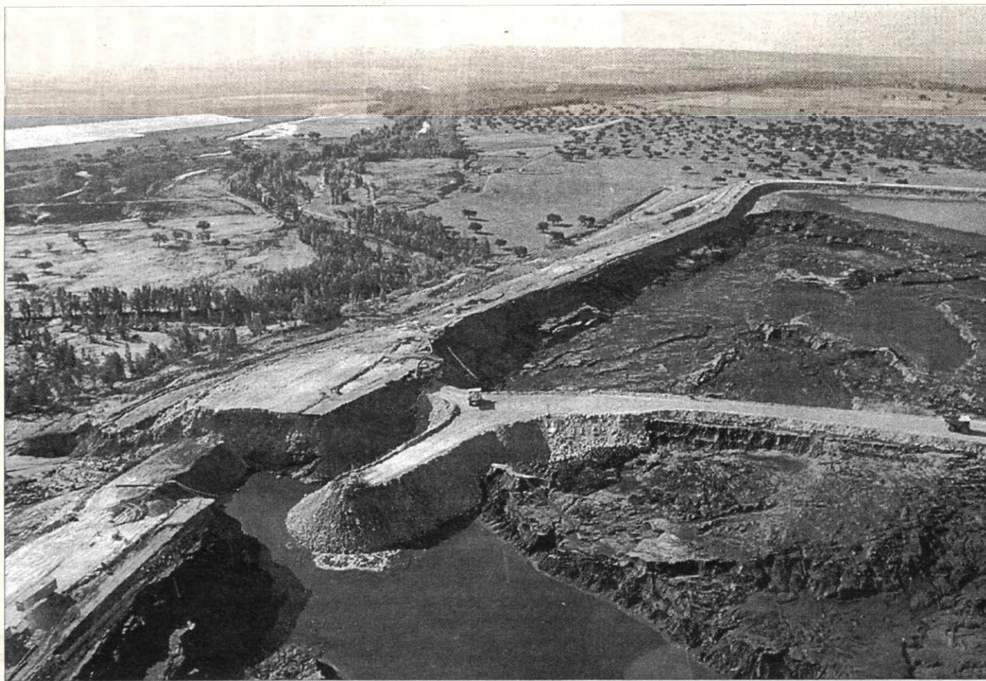
Imagen de la rotura de la presa de Aznalcóllar (Sevilla), ocurrida en 1998, que provocó el vertido de cinco hectómetros de aguas ácidas.
