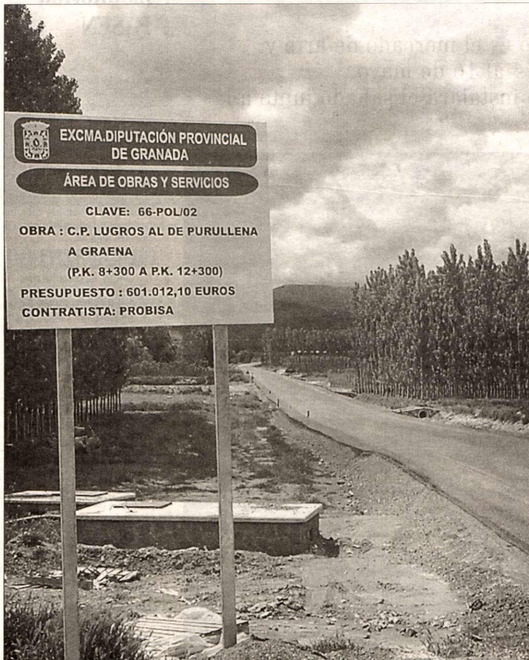
Obras en la carretera que une Purullena con Lugros.
