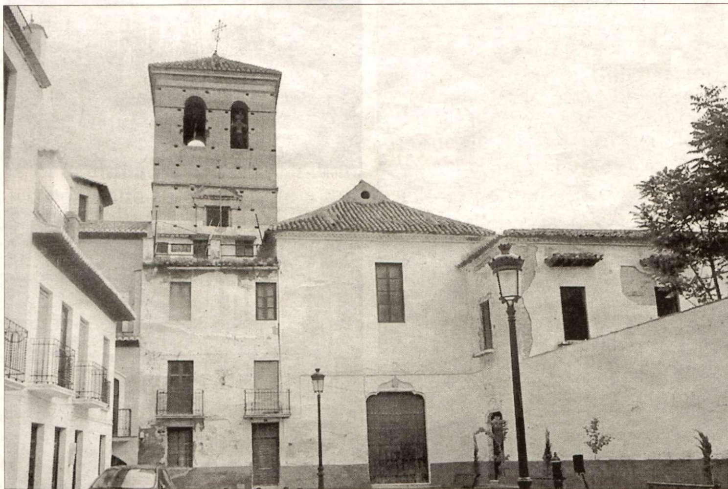
Iglesia y puerta del convento de San Francisco.
