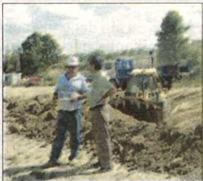
Obras del hospital.
