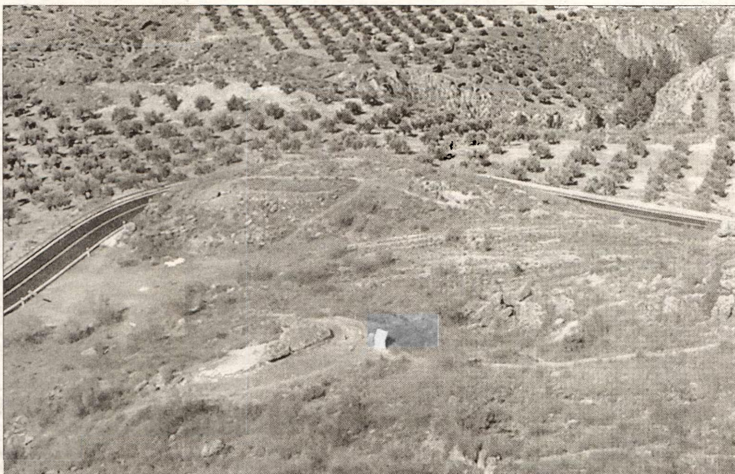
Carretera reformada de Gorafe.
