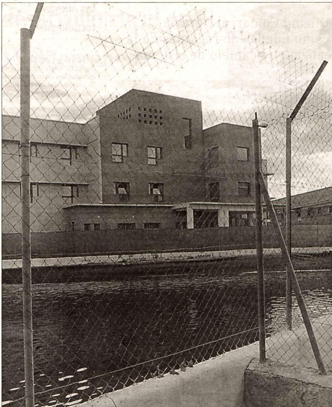
Además se convierte en un sitio peligroso para la gran cantidad de niños que transitan por la zona.
