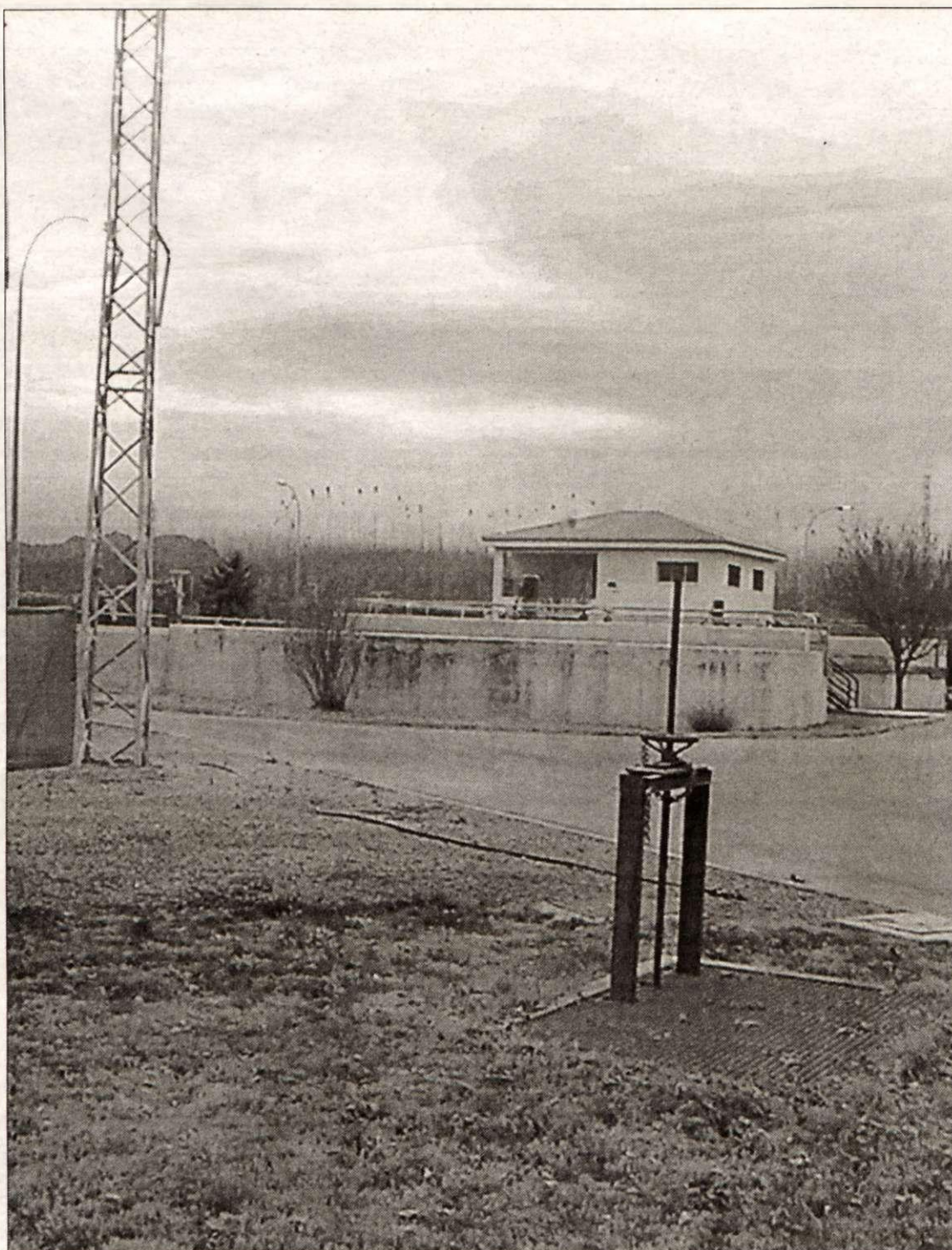
Depuradora de aguas residuales de Guadix.
