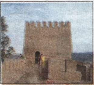
Inicio de las obras.
