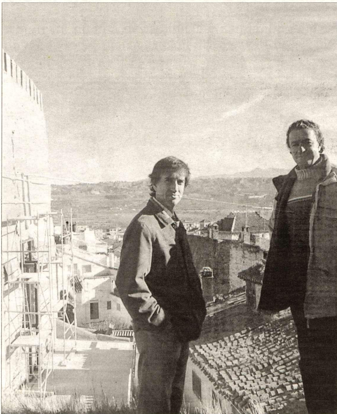
Manuel Gómez Vidal y Francisco Raya, junto a la obra de emergencia en uno de los torreones.
