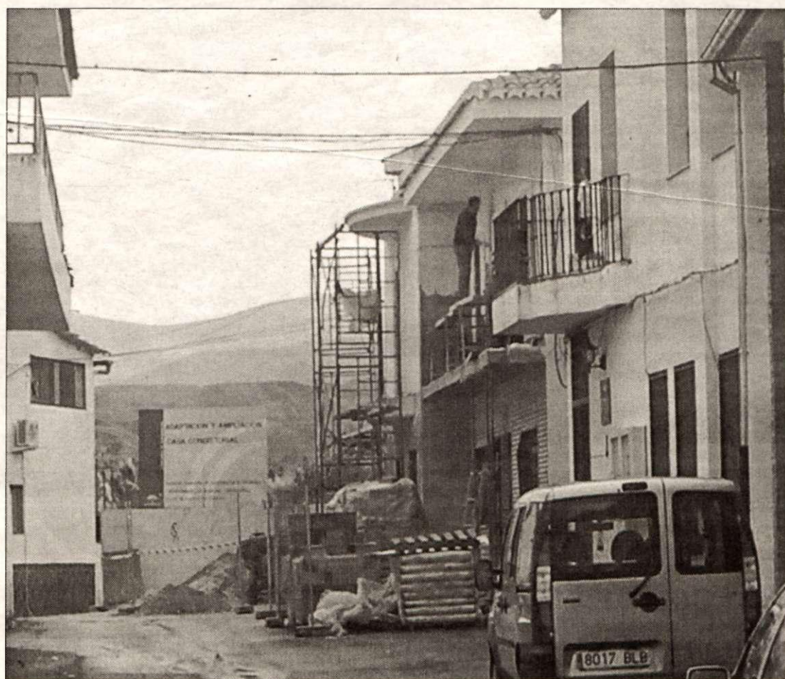
Obras del nuevo ayuntamiento de Marchal.
