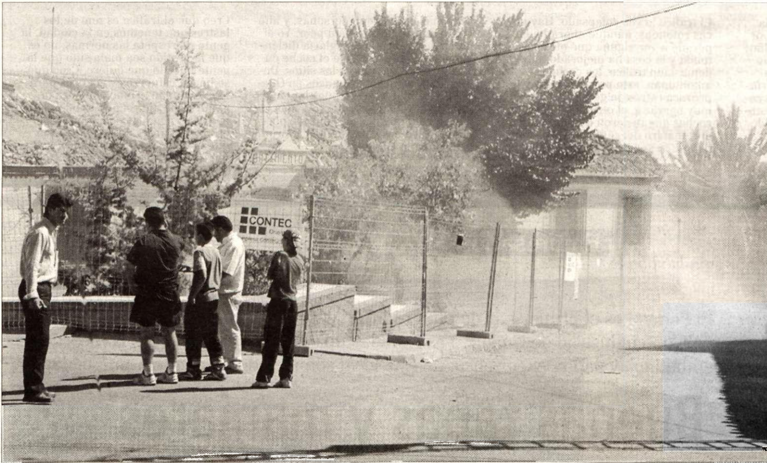
Demolición del ayuntamiento de Darro.
