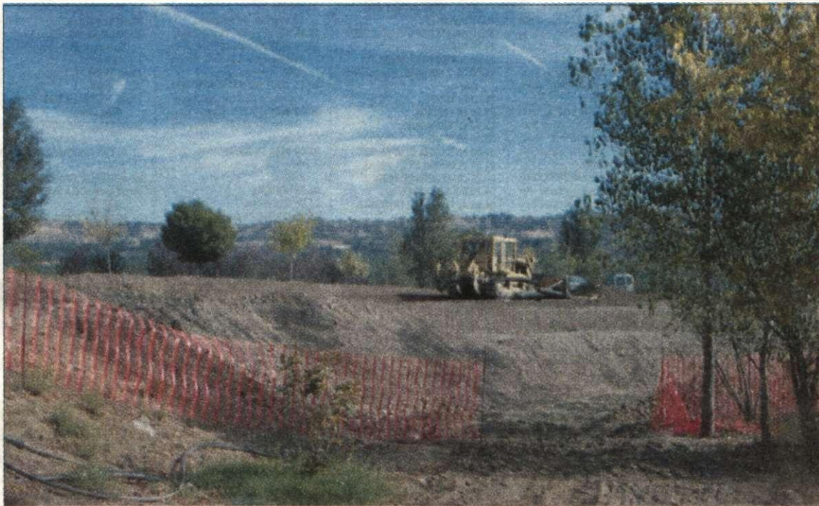
Obras que se están llevando a cabo en "El Vivero".
