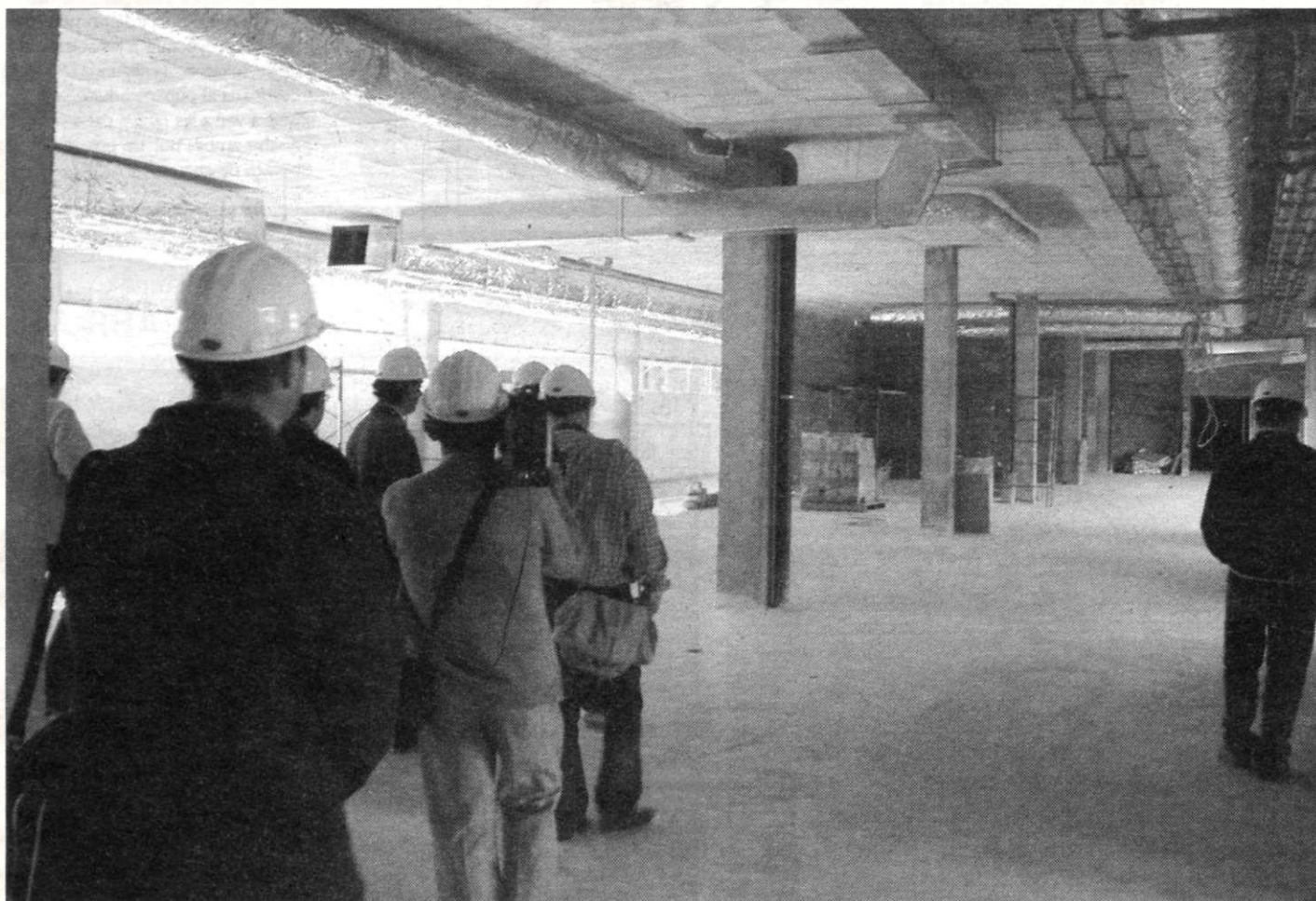
Zona de quirófanos del hospital, actualmente en construcción.
