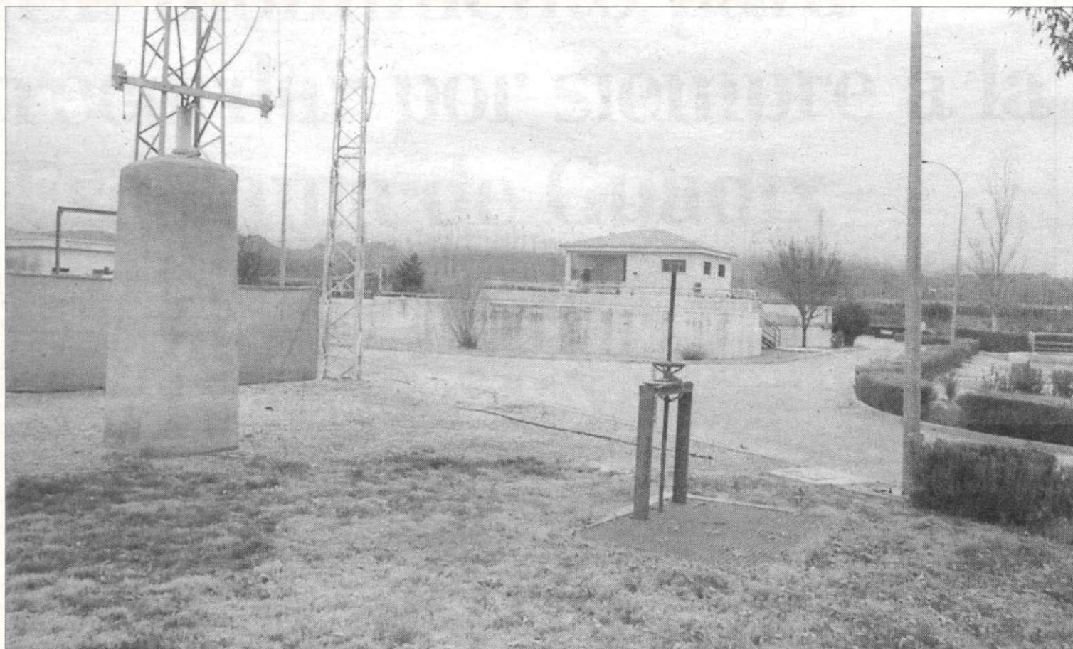
Depuradora de Guadix.
