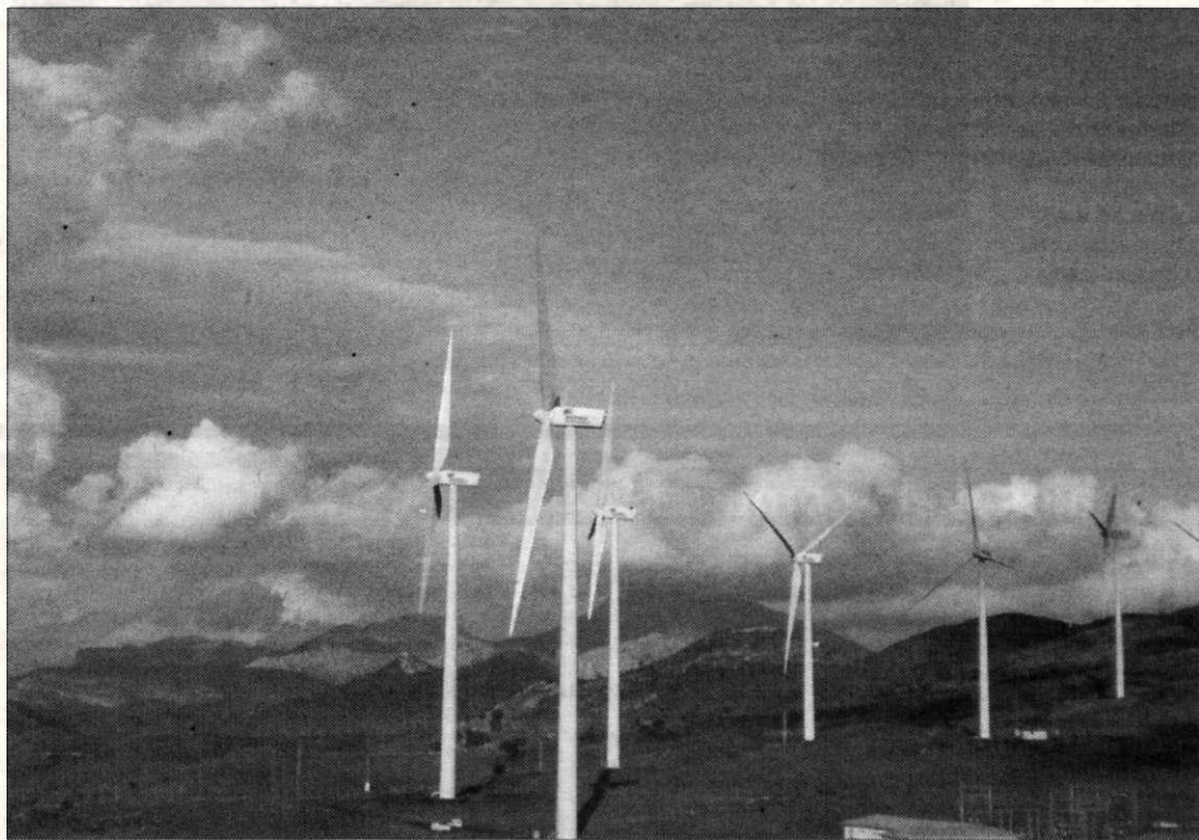
Las energías renovables, un sector con futuro.
