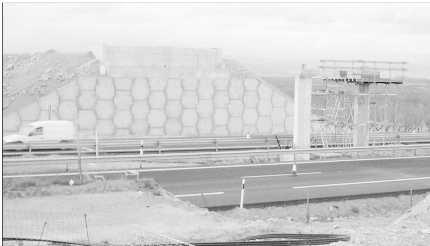
Obras que se están llevando a cabo en el segundo polígono industrial, donde se instalará Mercadona.
