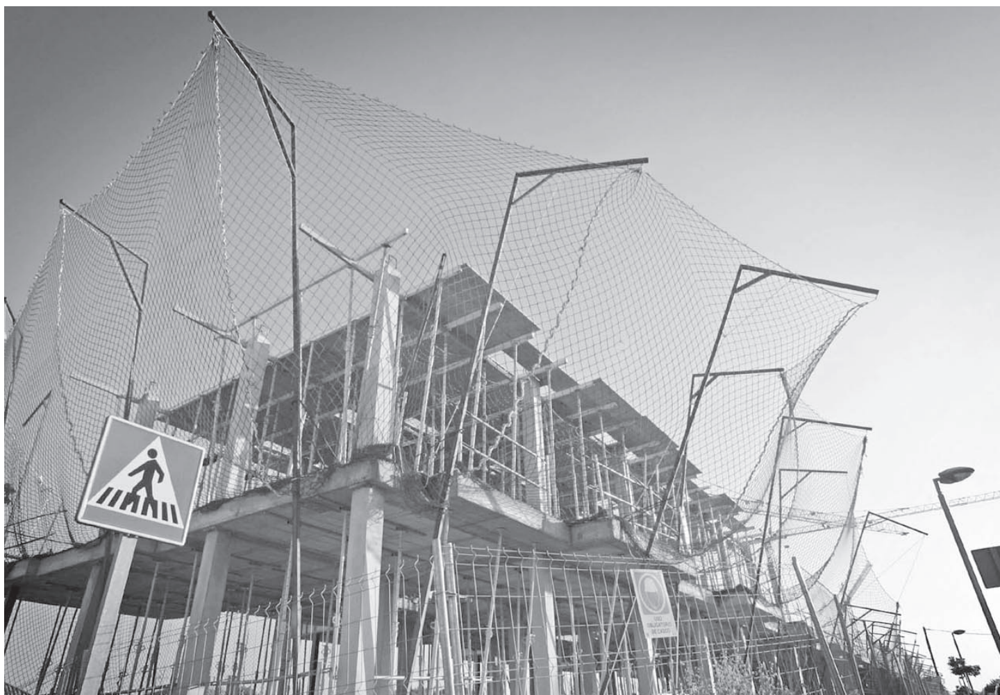
La construcción esta catalizando los mayores efectos negativos de la desaceleración, tanto a nivel de empleo como de empresas insolventes.
