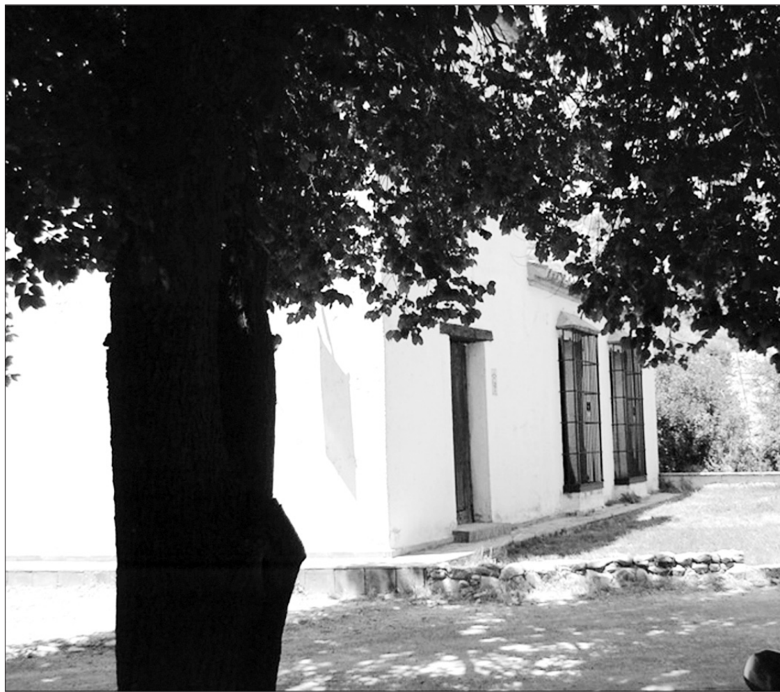
Exterior de la bodega del Marqués de Casa-Pardiñas, ubicada en Huélago.
