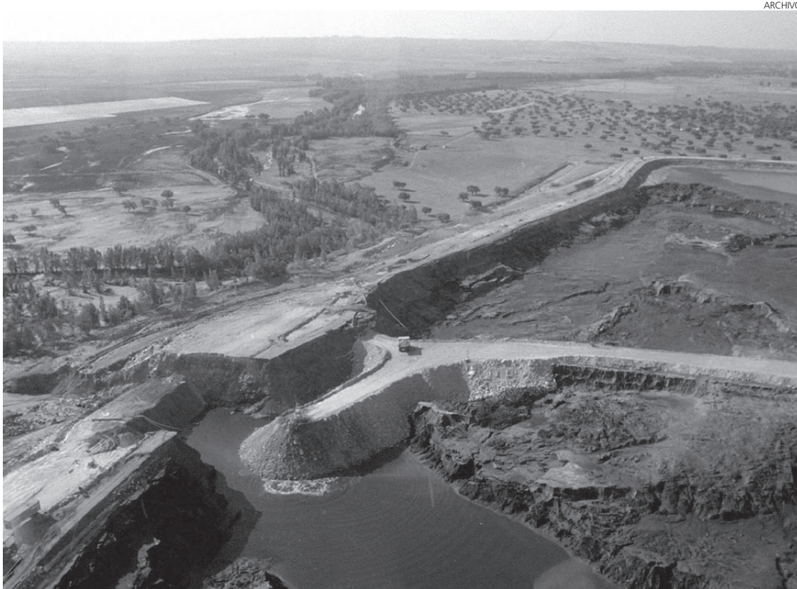
La responsabilidad, a nivel judicial, por la rotura de la balsa de lodos tóxicos aún no está clara diez años después.
