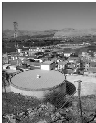
Imagen del nuevo depósito.
