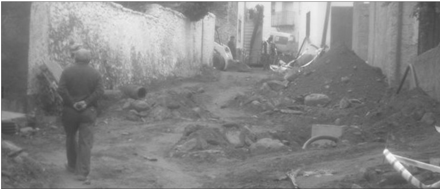
Una de las obras de los fondos "Proteja" que se están llevando a cabo en la comarca de Guadix.
