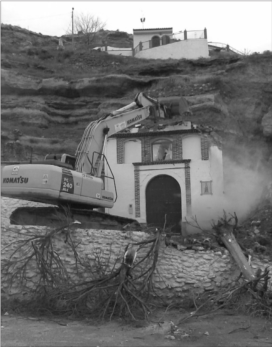
Comienzo de los trabajos en Belerda.
