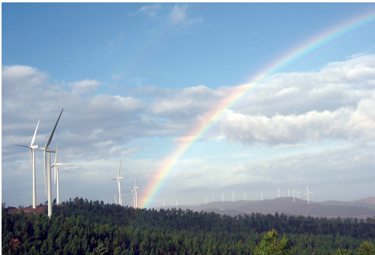
La comunidad autónoma andaluza posee 127 parques eólicos repartidos por toda la región, aportando 2.847MW de potencia eléctrica.
