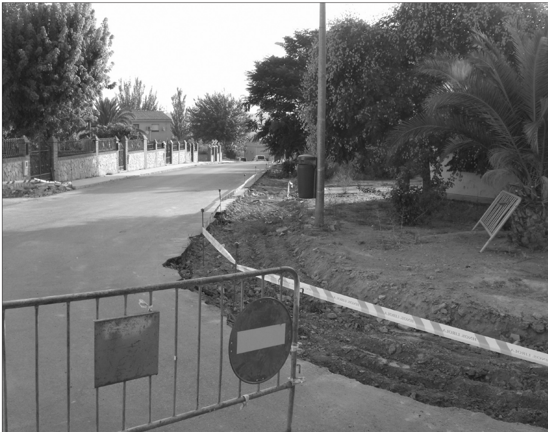
Las obras de la barriada de Andalucía ya han dado comienzo.
