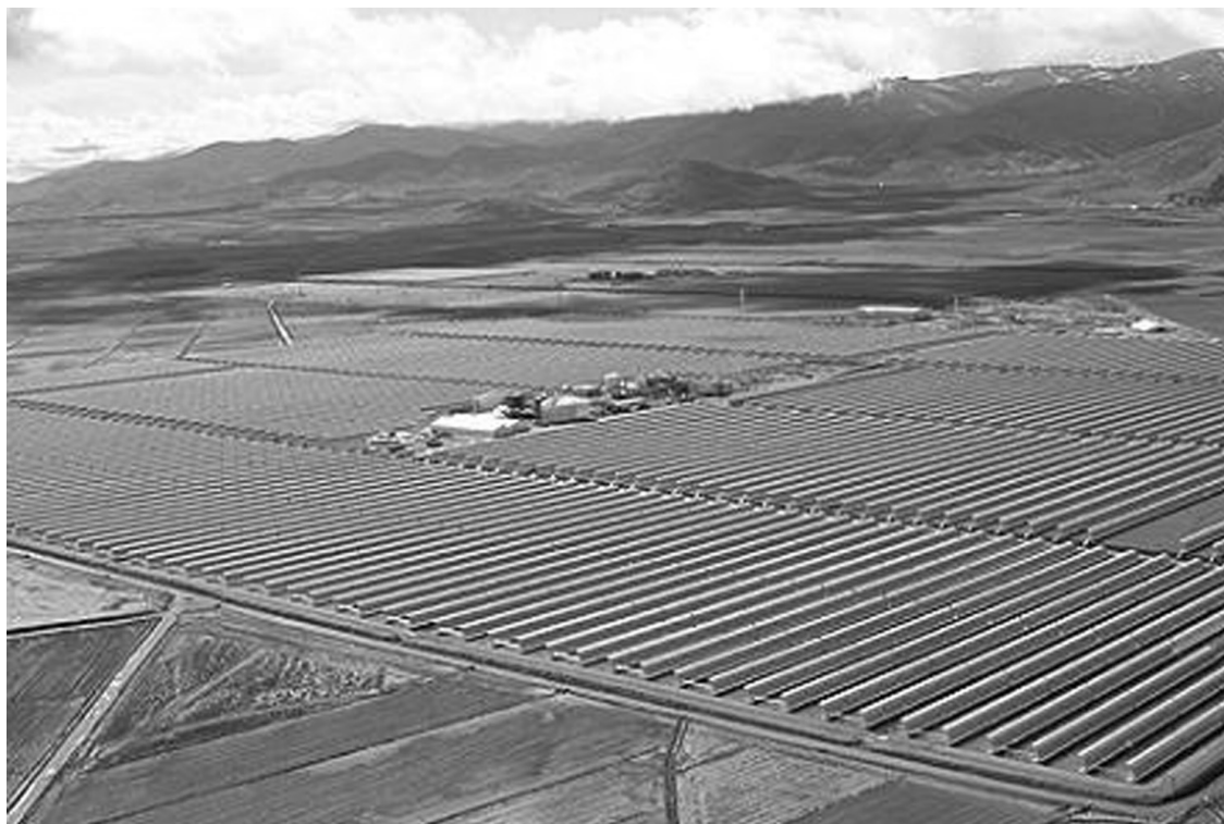
Planta termosolar andaluza.
