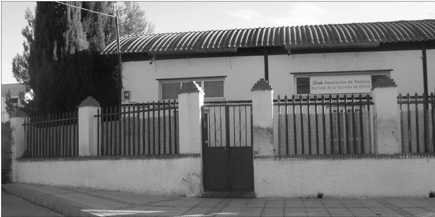
Lugar donde actualmente se está prestando provisionalmente la atención sanitaria en la Estación.
