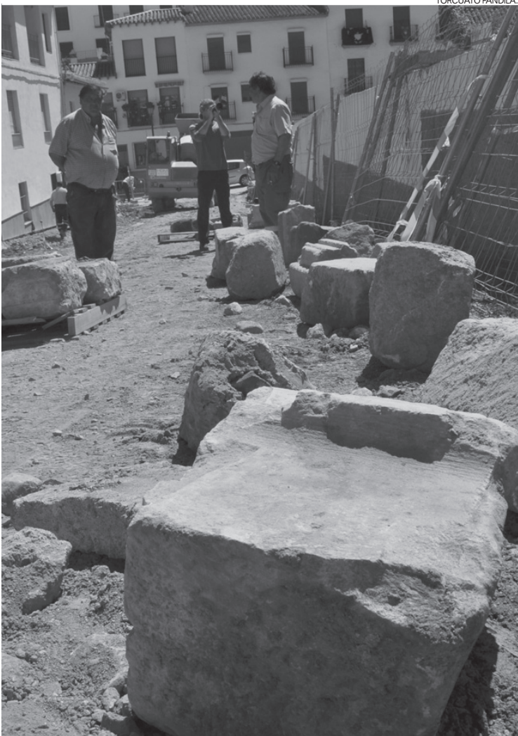
Restos aparecidos en las obras de Santo Domingo.
