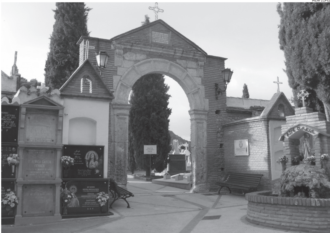
Entrada originaria del Cementerio de San José.
