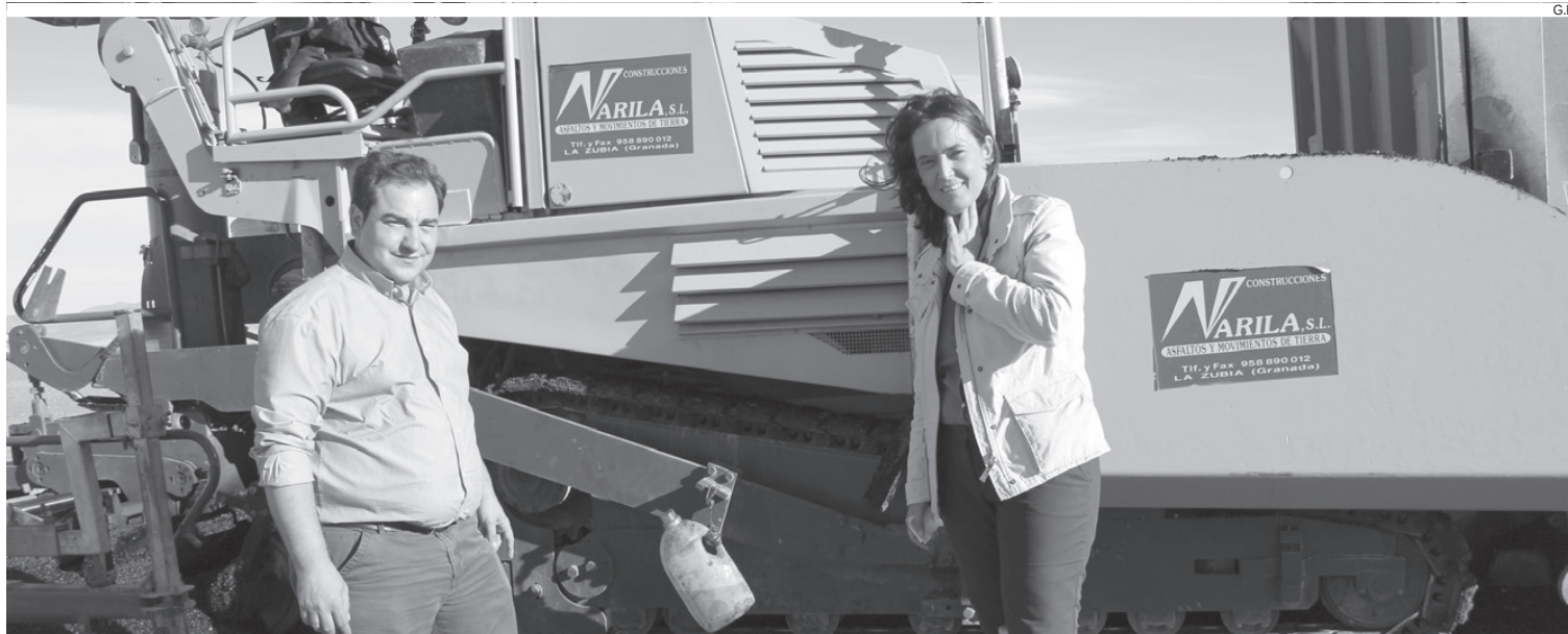
La diputada de Fomento y Obras Públicas visitó el estado de estas obras.
