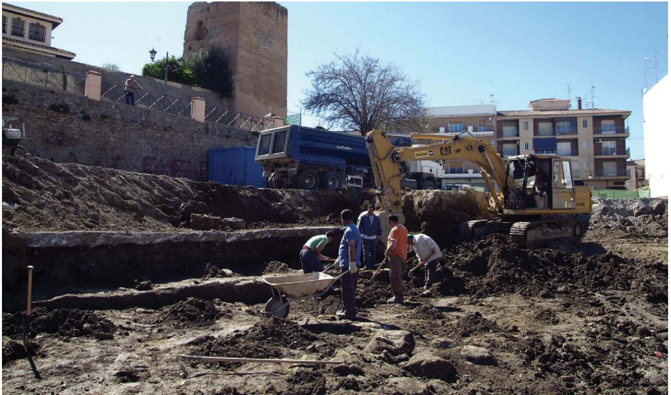
Actuales trabajos que se están llevando a cabo en el teatro romano.
