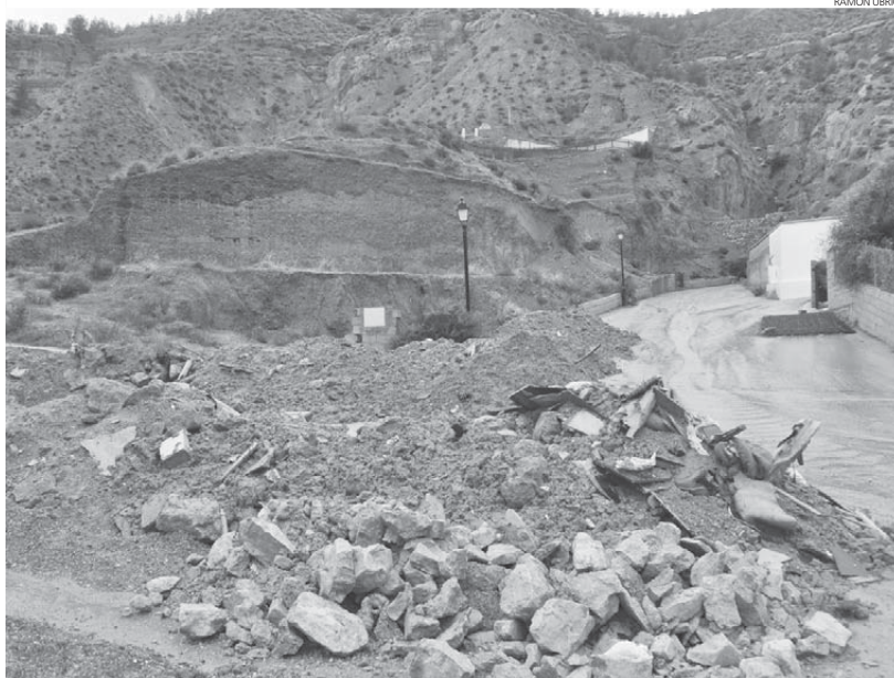
Derrumbes en Marchal.
