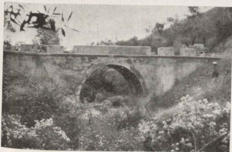
OBRA DE FABRICA EN EL CAMINO RURAL CHIVATILES-TINTA
