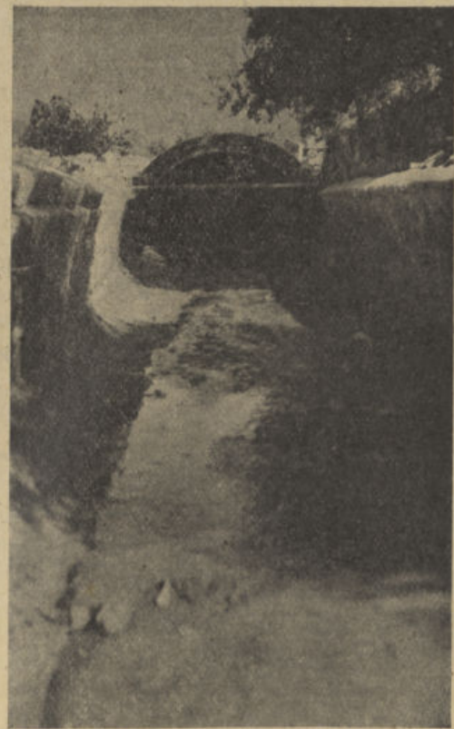
Obras del Colector Central de nuestra red de saneamiento. Realización importantísima y desconocida por gran parte del vecindario
