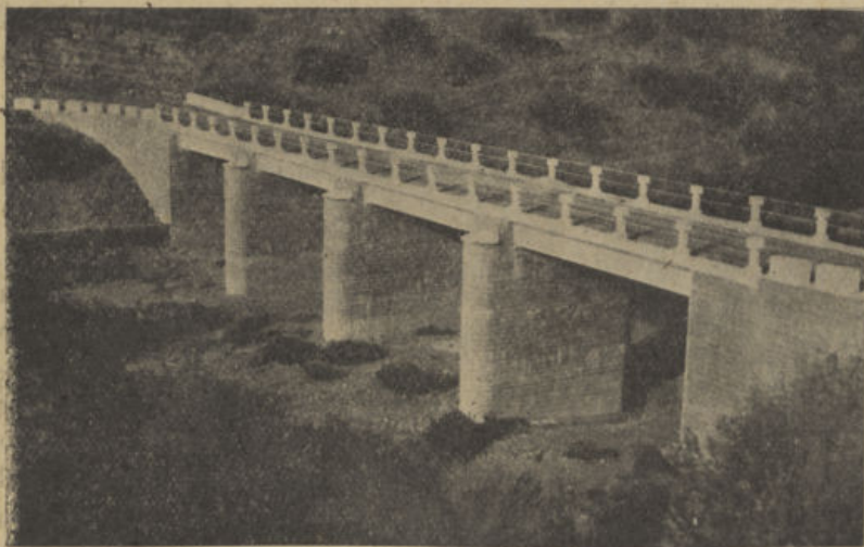
Nuevo puente sobre el río Cuzna, próximo a inaugurarse
