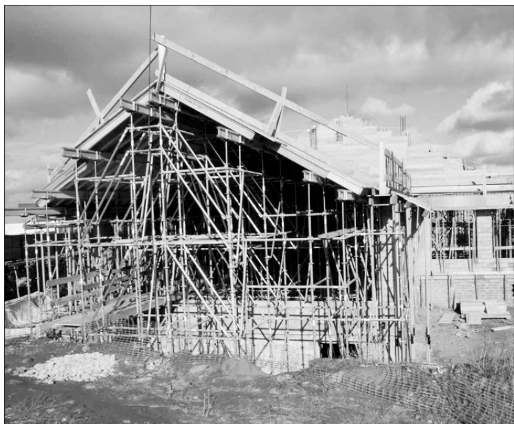
Estado de las obras.
