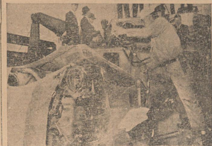
Obreros especializados de la Marina norteamericana, recubren con plastiflex, por medio de pistoles, los cañones y útiles de aquellos barcos de guerra apartados del servicio activo, a fin de preservarlos de la humedad.
