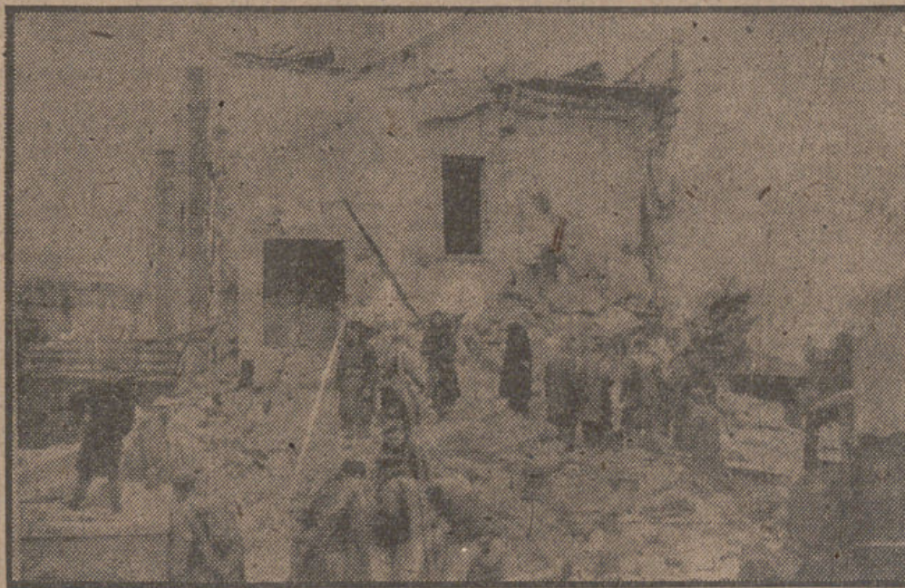
Estado en que quedó el hotel Semiramis, de Jerusalén, después de su reciente voladura por los terroristas judíos. En el suceso halló la muerte el cónsul adjunto de España en Jerusalén, don Manuel de Allendesalazar.
