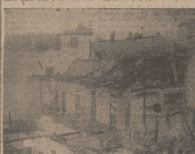
Los abnegados bomberos de Granada tuvieron una actuación meritisima con motivo del violento incendio que hace tres años destruyó el edificio de la Compañía Granadina de Industria y Comercio, en la calle de la Alhondiga. (Fot. ARCHIVO).
