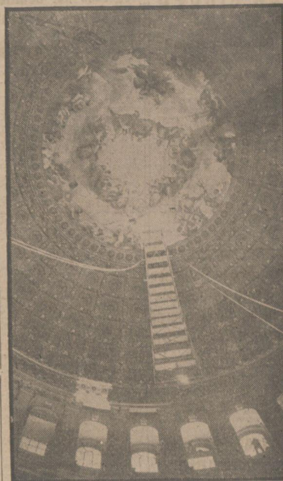
Se procede actualmente a una cuidadosa limpieza y restauración del Capitolio de Washington, para cuya labor se utilizan andamios de aluminio que se ciñen a la estructura semiesférica de la cúpula de aquel edificio. La fotografía muestra el interior de la cúpula, cuya altura de 35 metros está rematada por una colosal alegoría al fresco que representa la apoteosis de Jorge Washington, primer presidente de la Unión. Junto a ella puede verse el andamiaje de aluminio.
