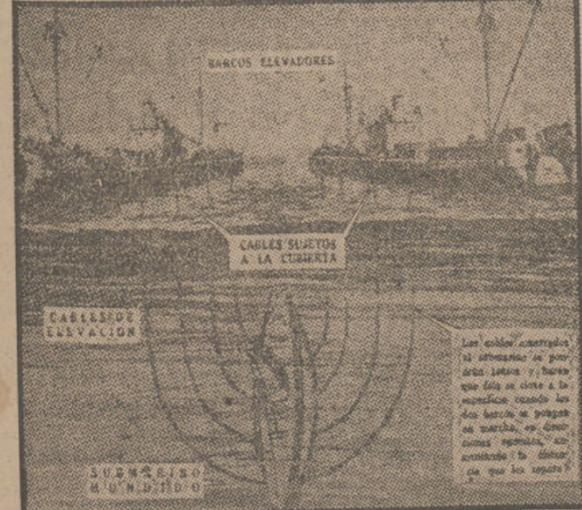
Este dibujo tiene a demostrar claramente, el probable sistema que el Servicio de Recuperación y Salvamento Naval británico empleará para sacar a la superficie el submarino "Truculent", hundido hace unos días en el estuario del Támesis a consecuencia de un choque con un mercante sueco.
