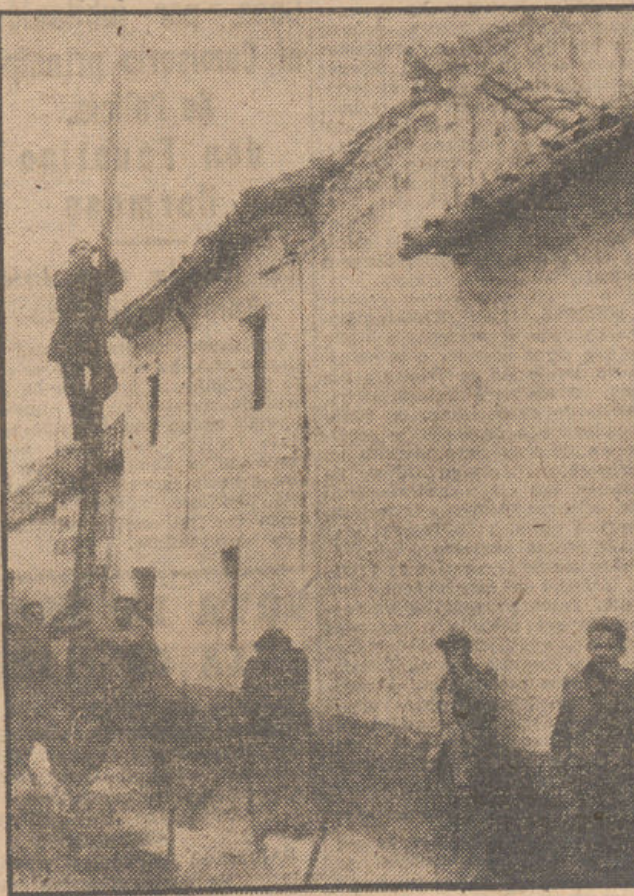
Una casa de la calle de San Juan de Palomares, en Córdoba, resultó gravemente afectada por el intenso movimiento sísmico del sábado. He aquí a los obreros trabajando en la reparación de la línea de conducción eléctrica. — (Fot. CIFRA GRAFICA).
